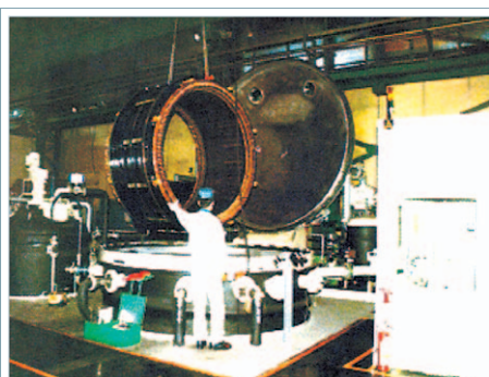
Пропитка смонтированных сердечника и катушки
