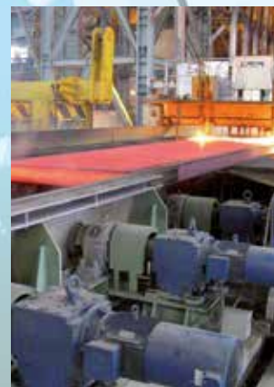
Приводы NORD на сталелитейном заводе.
