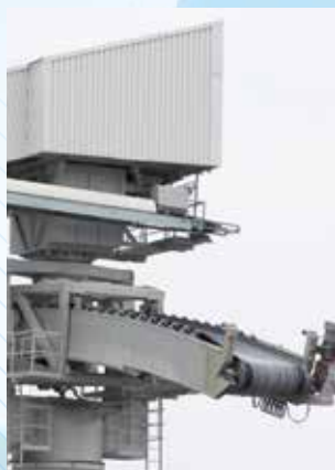
Привод NORD на щебеночном заводе NorStone AS в Норвегии.
