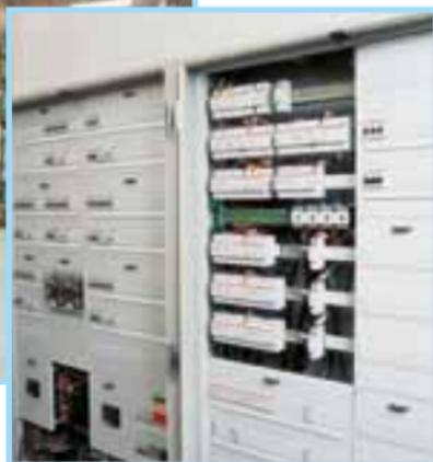
Модульные контакторы ESB предназначены для использования в щитах, совместно с модульными компонентами, устанавливаемыми на DIN-рейке. Катушка постоянного тока, применяемая в ESB, исключает вибрации при работе с переменным током и обеспечивает значительные преимущества, такие как, комфорт, тишину и спокойствие, что очень важно для офисов, больниц и любых мест проживания людей.
