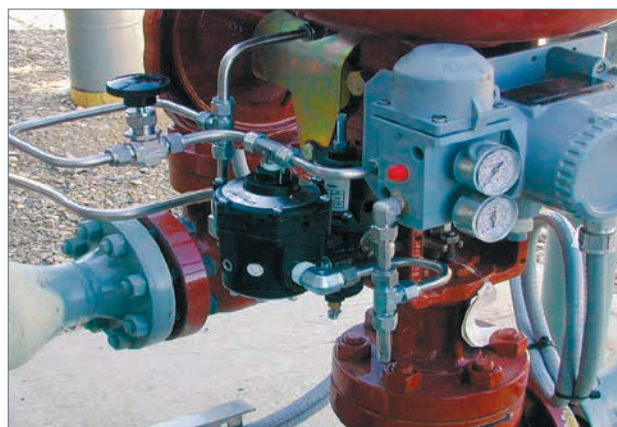
Объемные усилители M4500 для высоких расходов от Rotork Fairchild и прецизионные фильтрующие регуляторы M63 улучшают рабочие характеристики и отклик клапанных систем.
