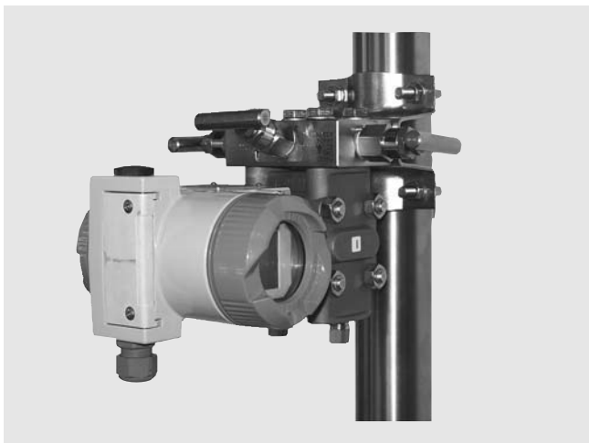
Вентильный блок 7MF9411-5BA со смонтированным измерительным преобразователем для дифференциального давления
