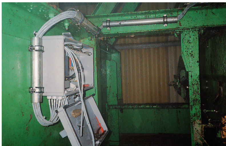
Прокладка кабеля в компостной установке
