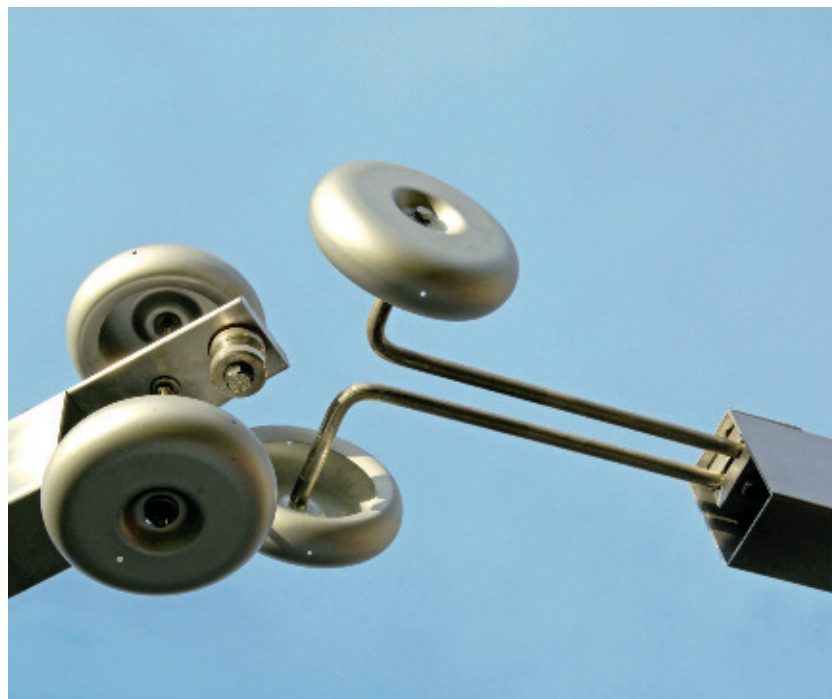
Рис. 23. Контакты главных ножей разъединителя
