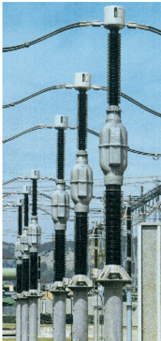
Рис. 42. Индуктивные трансформаторы напряжения с маслобумажной изоляцией 420 кВ
