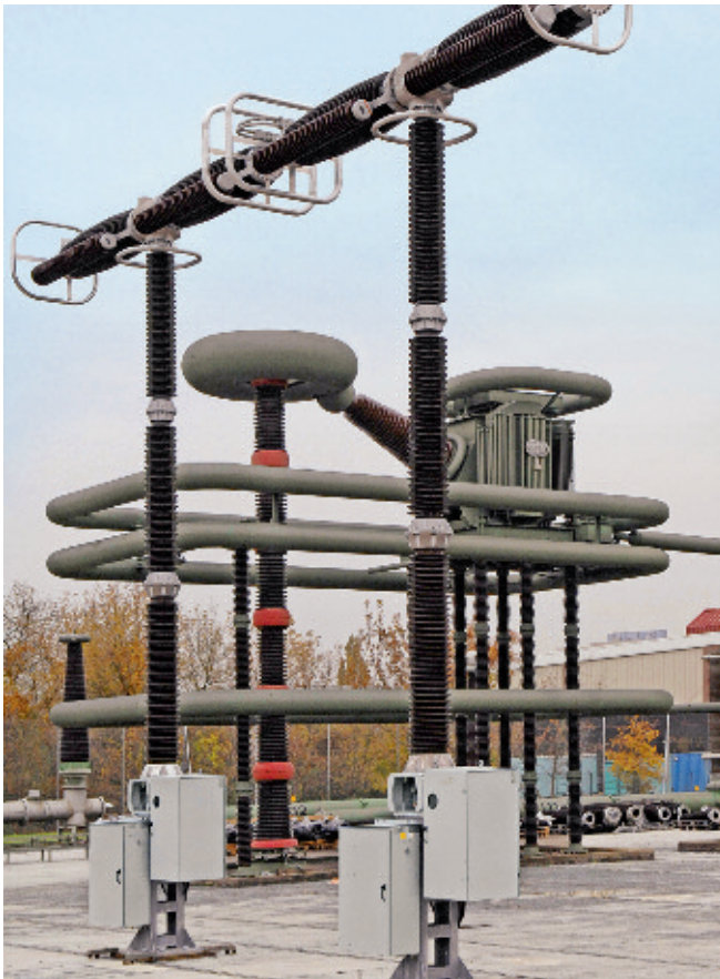
Рис. 5. Полюс выключателя ЗАР4 на 800 кВ
