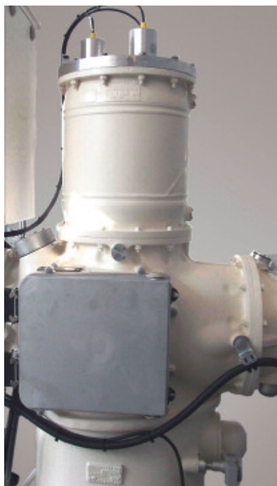
Рис. 52. Резонансно-емкостный делитель для газонаполненных подстанций 145 кВ
