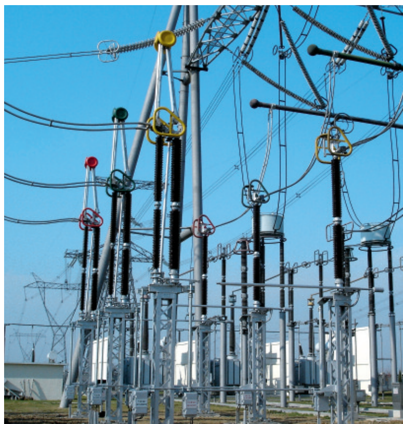
Рис. 27. Полупантографный разъединитель
