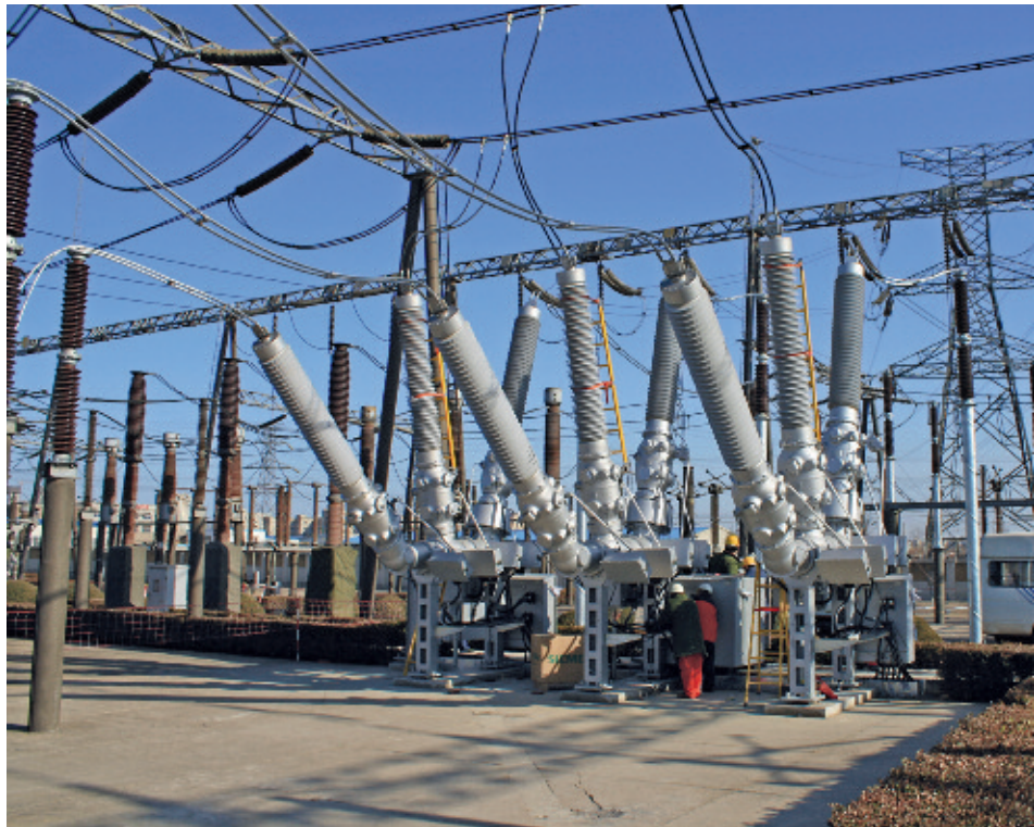
Рис. 16. ЗАР1 DTC 245 кВ
