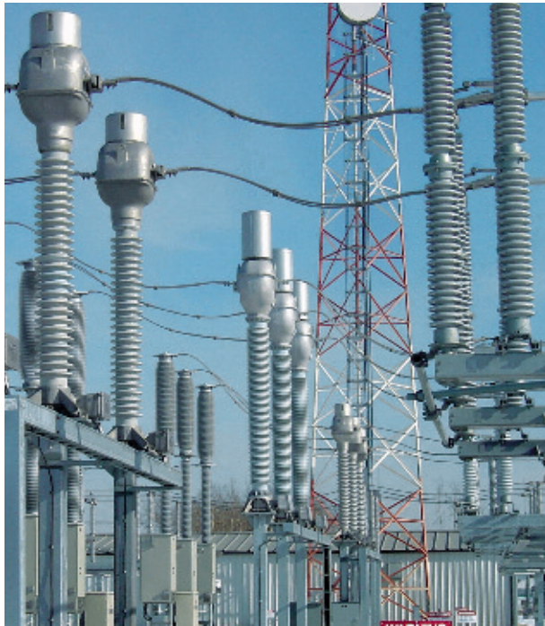
Рис. 49. Масляные трансформаторы тока Trench
