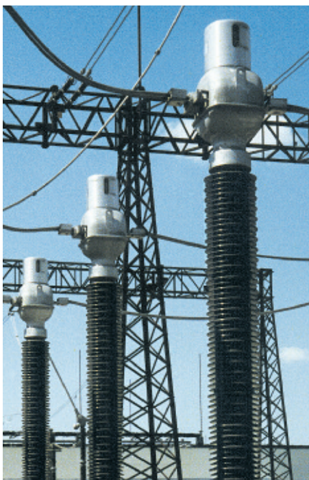
Рис. 40. Масляные трансформаторы тока 550 кВ
