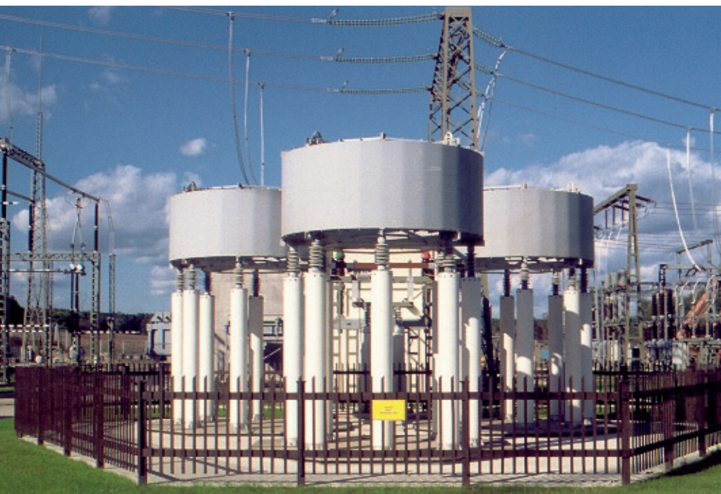
Рис. 57: Объединенные в тройки шунтирующие реакторы
