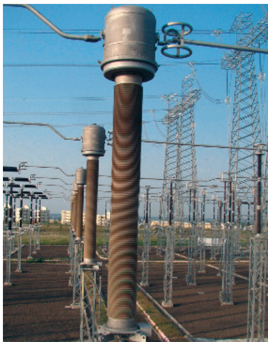
Рис. 39. Газоизолированные трансформаторы тока 800 кВ
