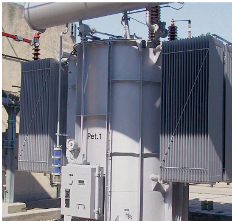
Рис. 59: Дугогасящая катушка 110 кВ
