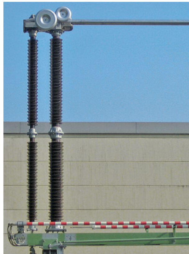
Рис. 25. Пантографный разъединитель
