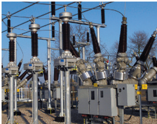
Рис. 15. ЗАР1 DTC 145 кВ
