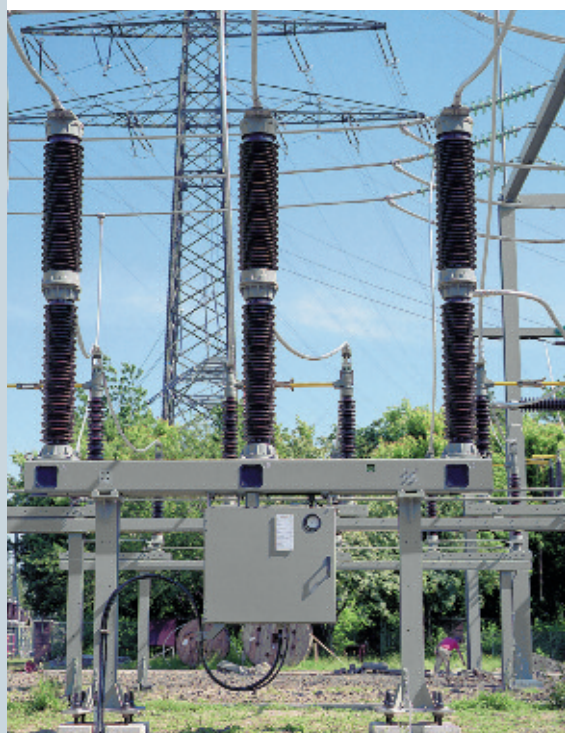
Рис. 9. Выключатель ZAP1FG-126
