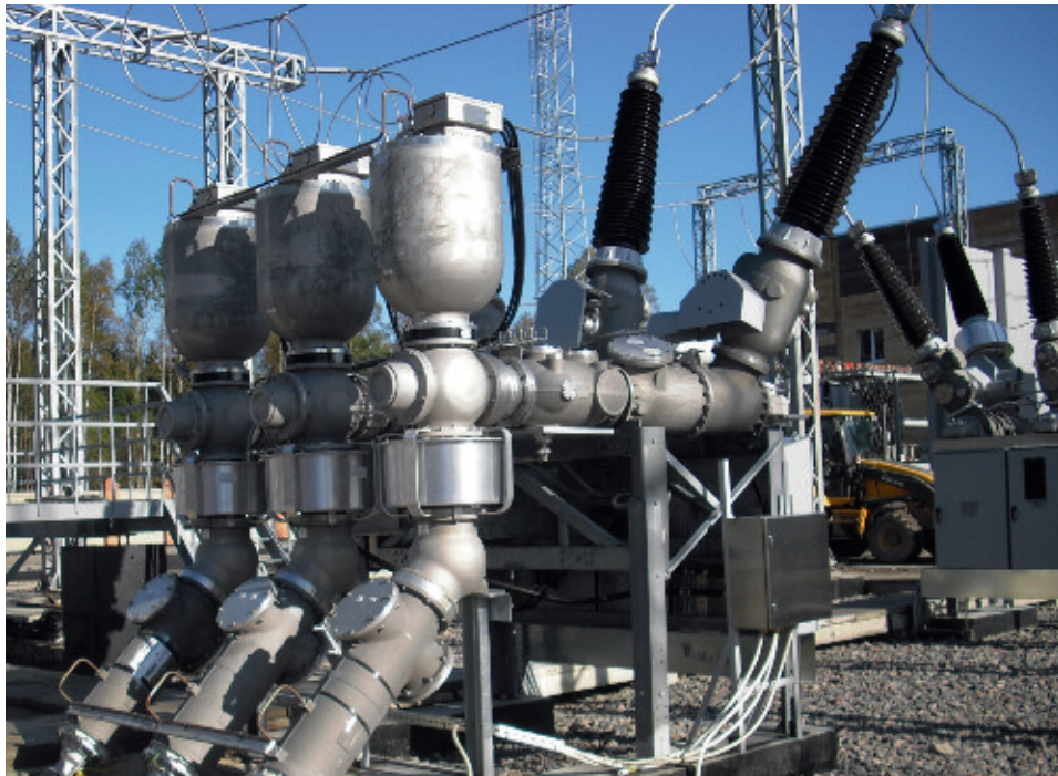
Рис. 18. Выключатель ZAP1 DTC для 145 кВ с трансформатором напряжения и кабельным вводом
