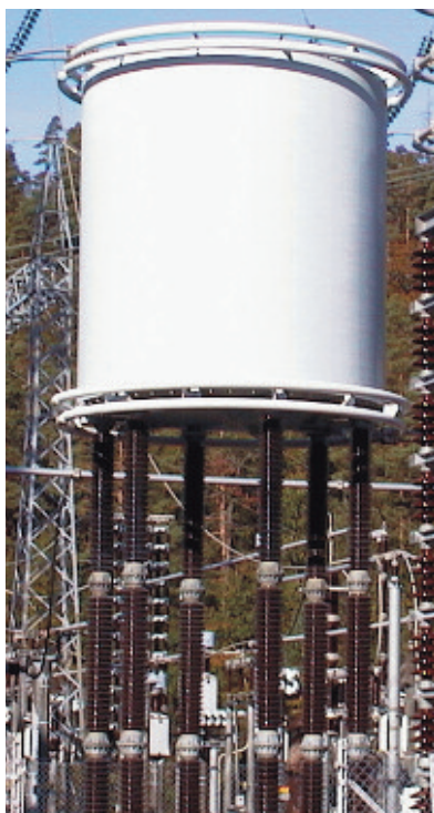
Рис. 58: Сглаживающий высоковольтный реактор постоянного тока
