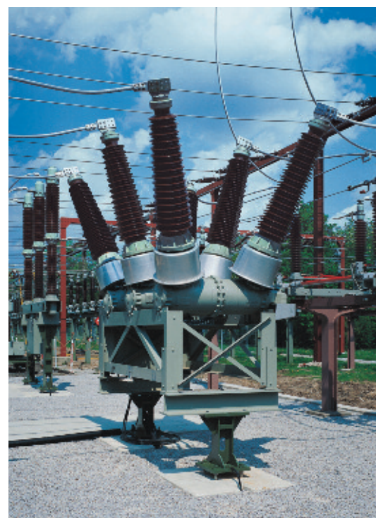
Рис. 11. Выключатель ZAP1DT-145
