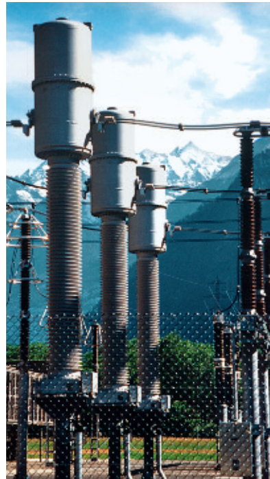
Рис. 50. Газонаполненные комбинированные измерительные трансформаторы 420 кВ
