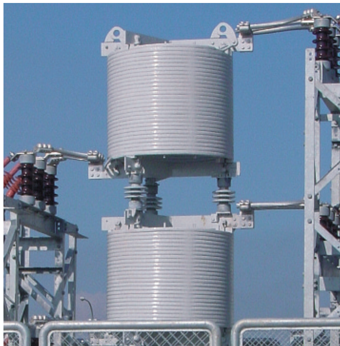
Рис. 56. Трехфазный многоярусный токоограничивающий реактор
