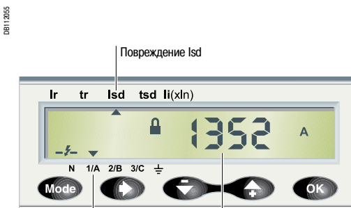
Индикация тока повреждения
