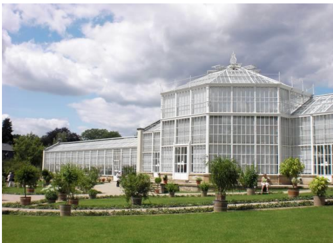
Пальмовая оранжерея в парке дворца Пиллнитц в Дрездене Чугунные балки
