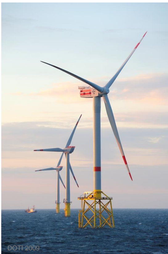
REpower Systems SE 5M – 5,4 МВт Ветропарк «alpha ventus»
