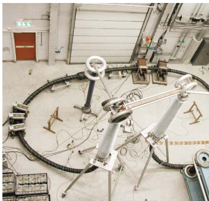
Испытания концевых кабельных муфт Kabeldon APECB 245 P и соединительных JS-A 245 в независимой лаборатории.
