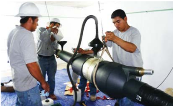
Наши концевые кабельные муфты можно собирать горизонтально на земле и затем поднимать на место установки — просто и безопасно.
