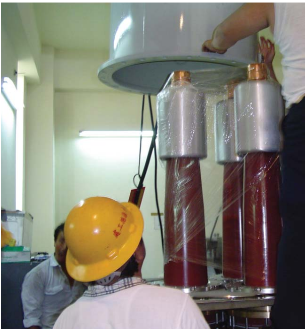
Концевые кабельные муфты типа APEGA в элегазовых вводах КРУЭ.
