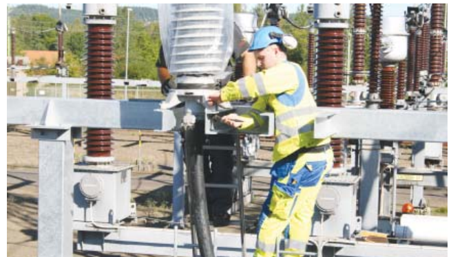
Монтаж композитных концевых кабельных муфт, АРЕСВ.
