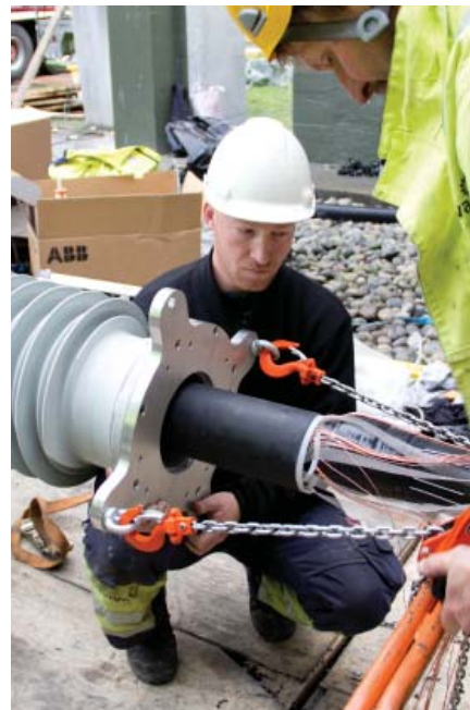
Монтаж сухой концевой муфты, TD 145 кВ.
