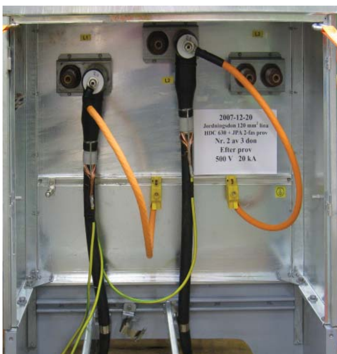
Испытание короткого замыкания, HDC-A.
